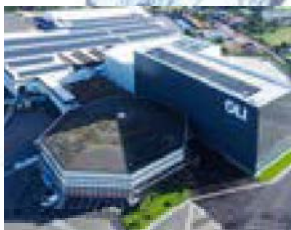
Stabilimento - Portogallo Plant - Portugal
