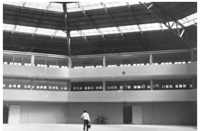
Interno dell'edificio ottagonale
