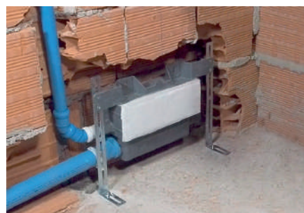
Aplicação em parede de alvenaria
