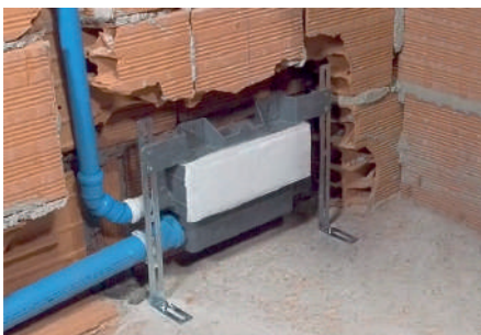
Aplicação em parede de alvenaria
