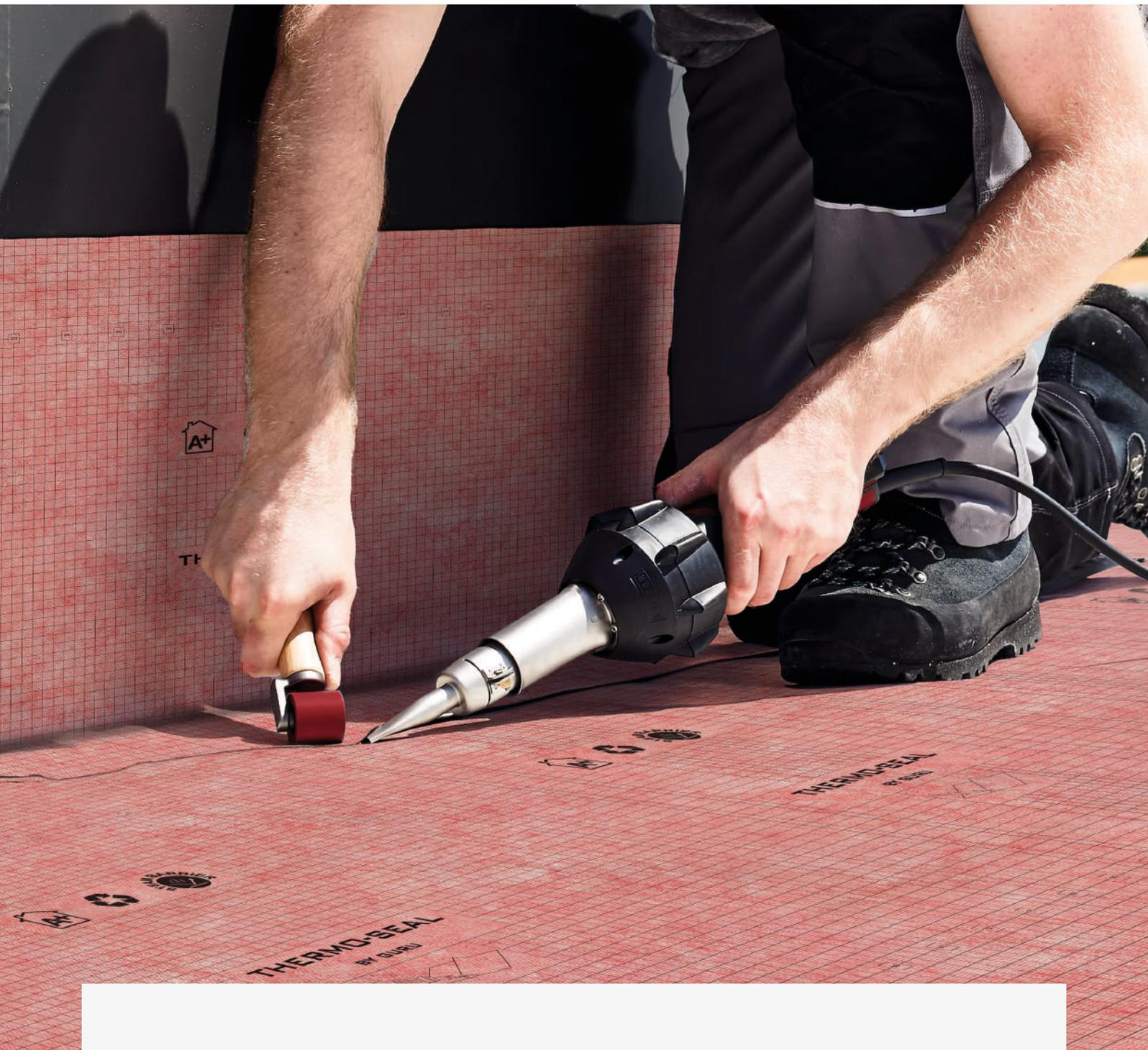
THERMO SEAL é uma lâmina geotêxtil **impermeável e termosoldável** que oferece uma proteção e desempenho excepcionais. A sua lâmina central, com um maior conteúdo de plástico, permite a selagem de juntas através de um soldador térmico, garantindo uma impermeabilização contínua e sem interrupções.
