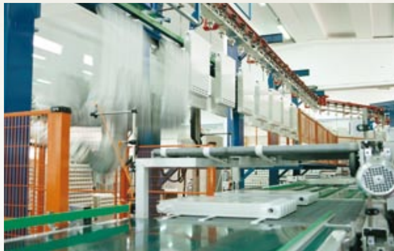
· Il moderno impianto di imballaggio e verniciatura · The modern paint and packaging system
